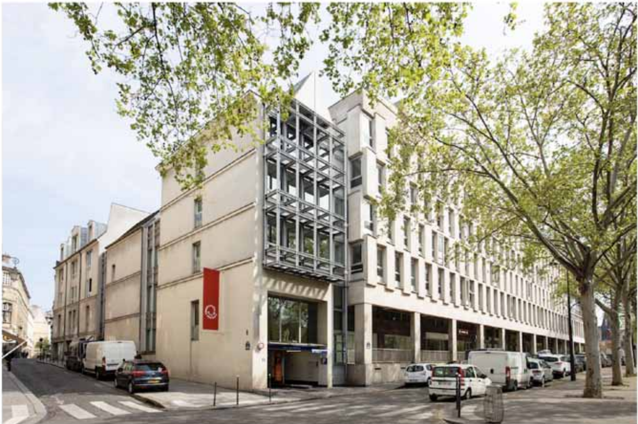
Cité internationale des arts - vue depuis la rue de l'Hotel de Ville
